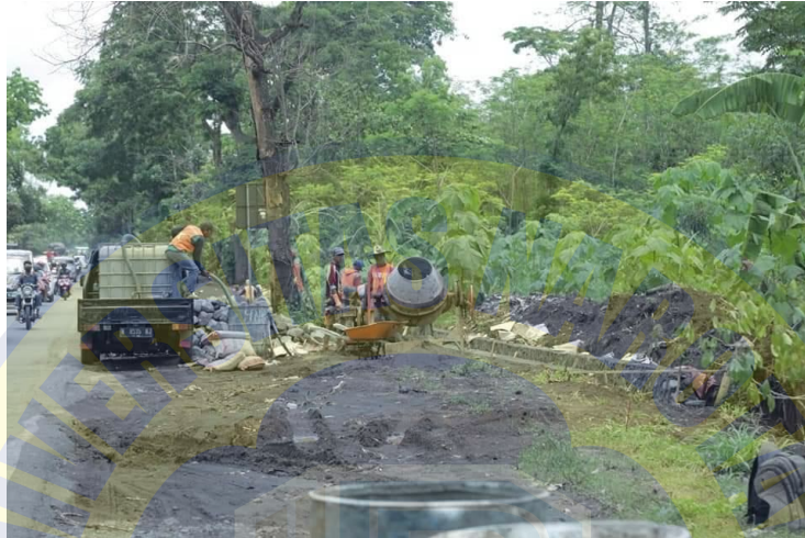
Lampiran 1. Foto Dokumentasi Pengerjaan Timbuan KM 135 + 500
