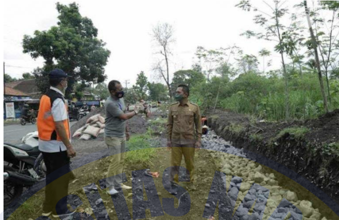
Lampiran 4. Foto Dokumentasi Pengerjaan Timbunan KM 137 + 400
