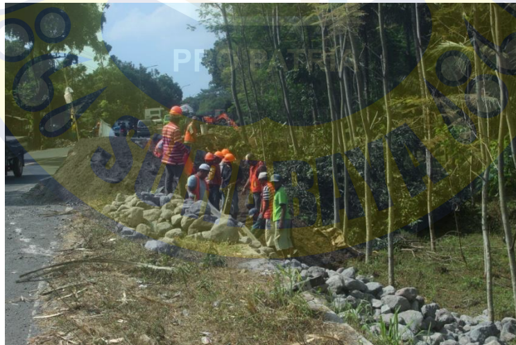
Lampiran 2. Foto Dokumentasi Pengerjaan Timbunan KM 135 + 800
