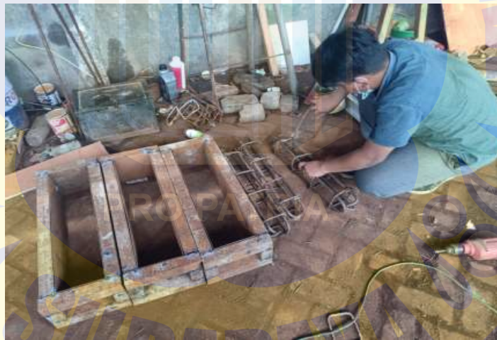
Gambar 3. 5 Proses Pembuatan Tulangan Besi Normal
