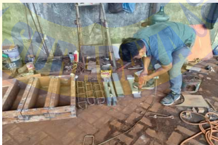
Gambar 3. 3 Proses Pembuatan Tulangan
