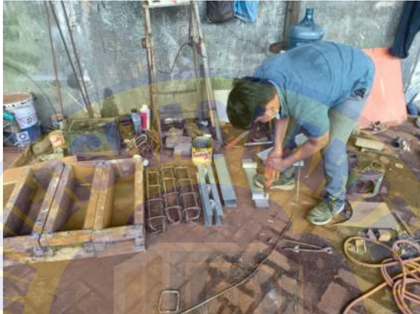
Gambar 1.1 Proses Perakitan Tulangan Profil C Baja Ringan
