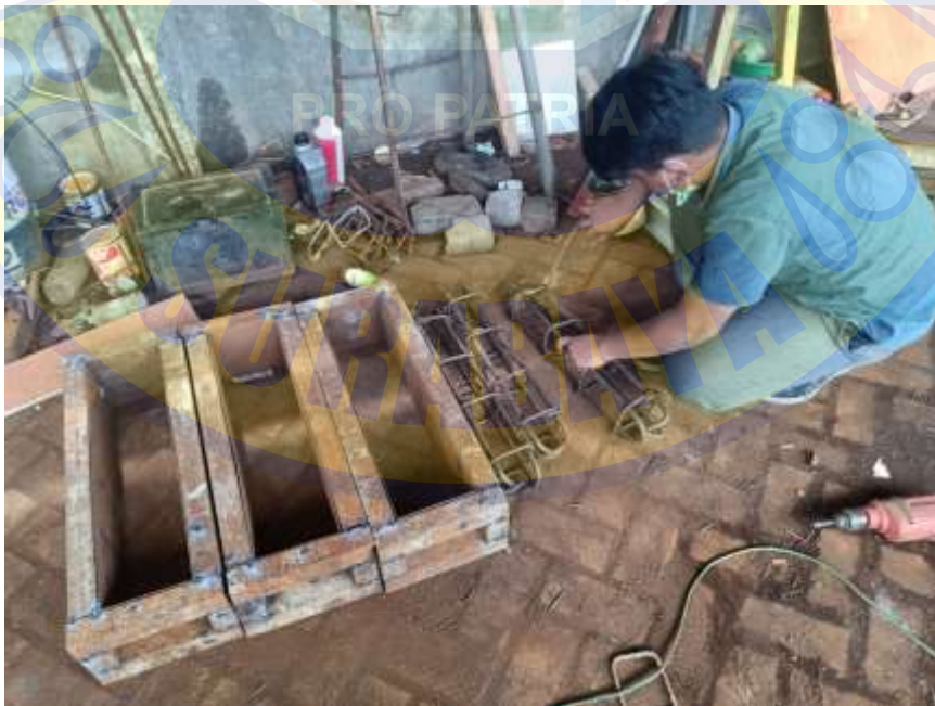
Gambar 1.2 Proses Perakitan Tulangan Besi Normal
