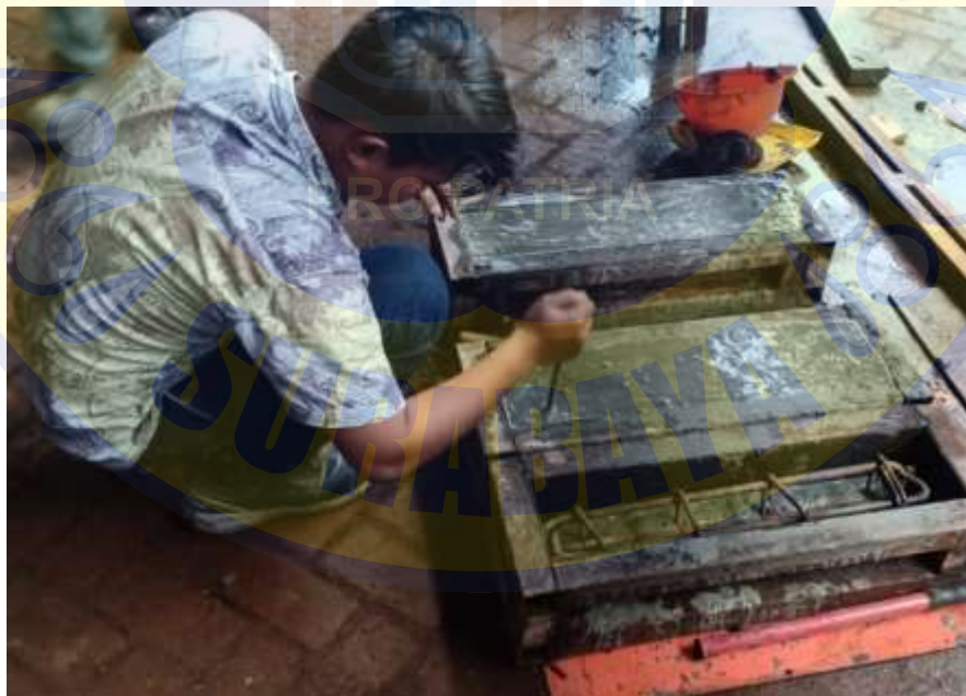
Gambar 1.6 Proses Pengecoran Tulangan Besi Normal
