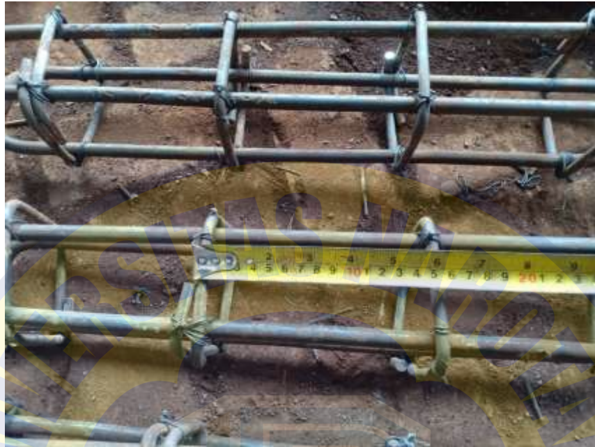
Gambar 1.3 Proses Pengukuran Jarak Senggang Begel
