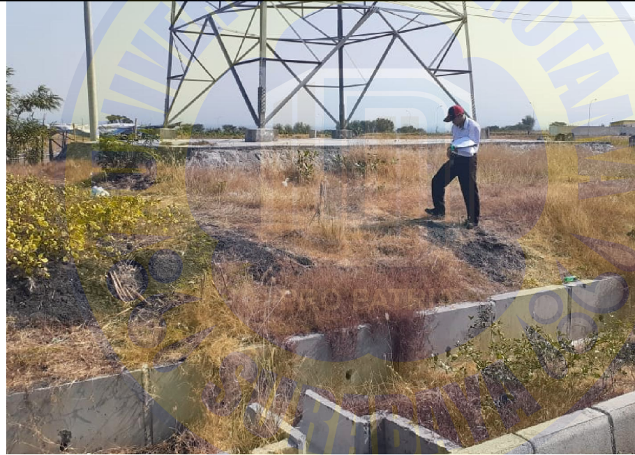
Pengecekan Kondisi Jaringan Perpipaan untuk rencana jaringan pipa baru
