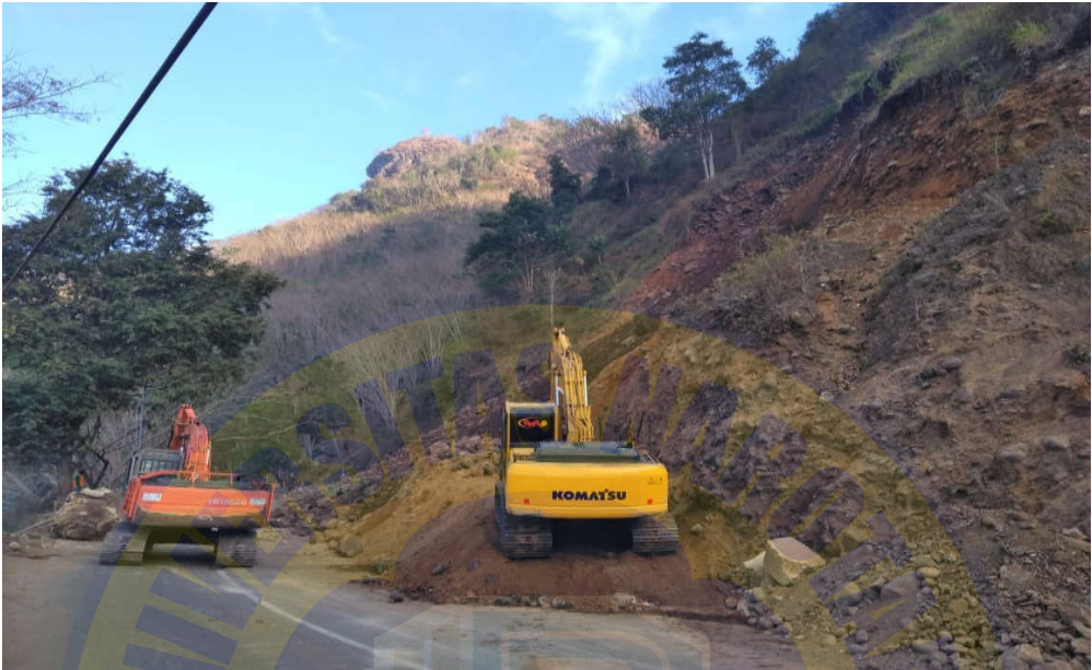
Lampiran 6 : Foto Pelaksanaan Proyek Penanganan Lereng
