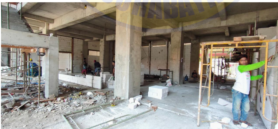
Lampiran 9 Pemasangan Dinding
