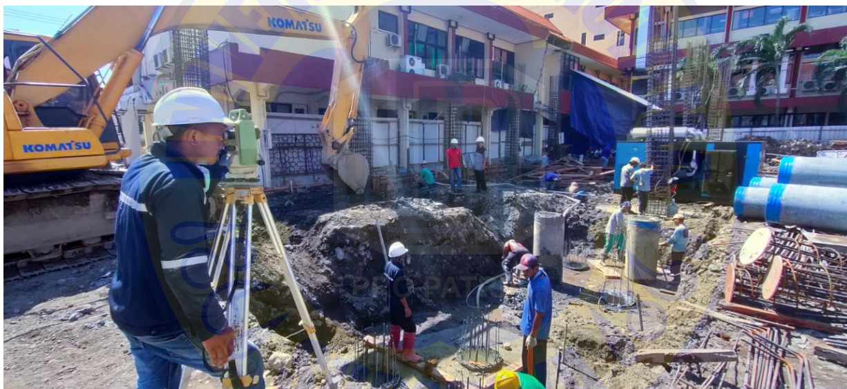
Lampiran 14 Pekerjaan Pengukuran Menggunakan Waterpass
