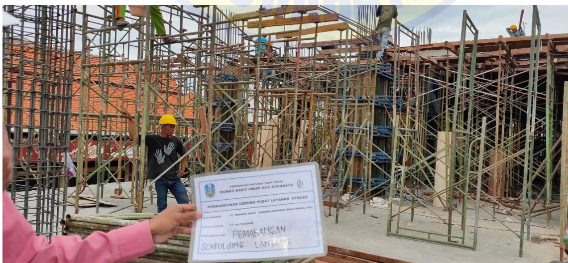
Lampiran 12 Pemasangan Scaffolding LT.6
