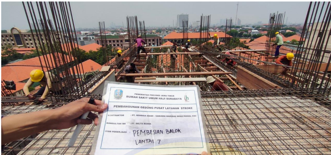
Lampiran 8 Pemasangan Skafolding
