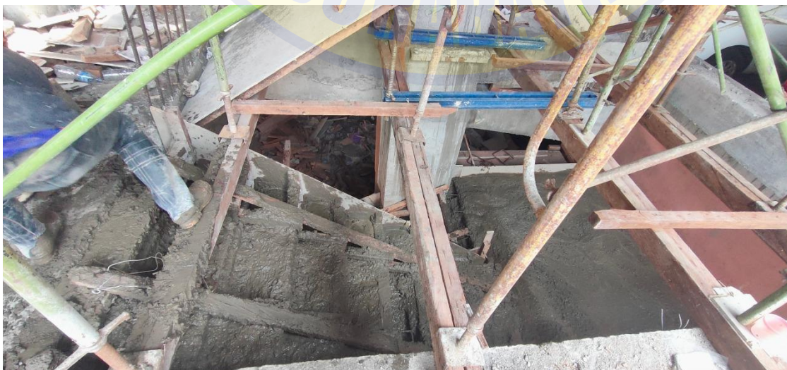
Lampiran 6 Pengecoran Tangga
