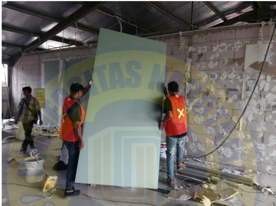
**Gambar 4.5 Pemasangan Papan Gypsum pada Dinding Bata Ringan**
