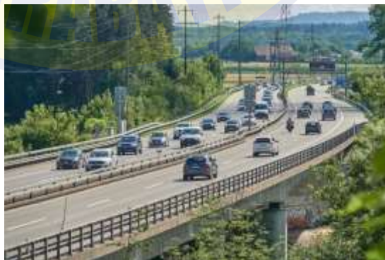
Gambar 2.1 Jembatan Jalan Raya
