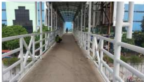
Gambar 2.3 Jembatan Pejalan Kaki
