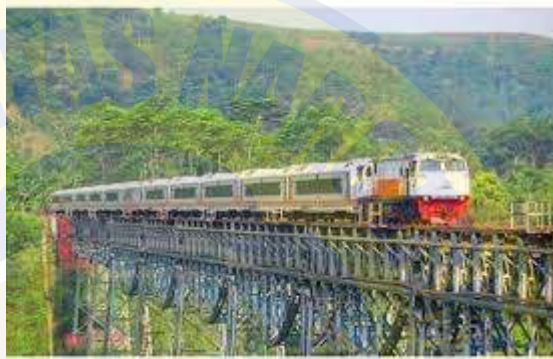
Gambar 2.2 Jembatan Jalan Kereta Api
