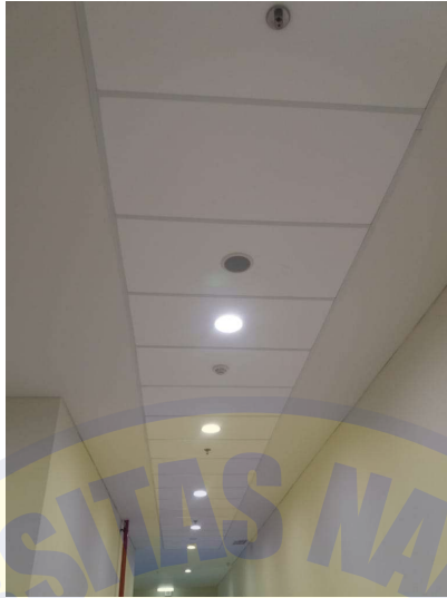
Gambar 4.11 Pekerjaan plafon gypsum tile area selasar
