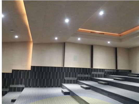
Gambar 4.6 Pekerjaan plafon akustik heradesign
