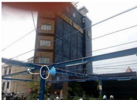
Gambar 10. Pemasangan Access Point
