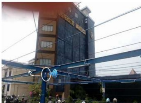
Gambar 10. Pemasangan Access Point
