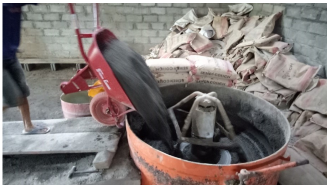
Gambar 8.6 Penuangan pasir ke mixer
