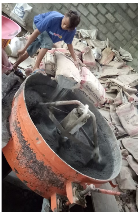
Gambar 8.7 Penuangan semen ke dalam mixer
