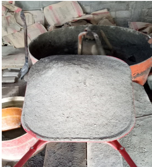
Gambar 8.5 Penuangan pasir ke mixer
