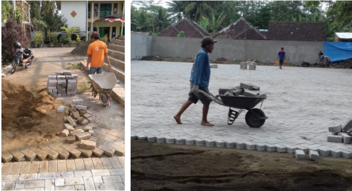
Gambar 1.1. Pekerjaan paving
