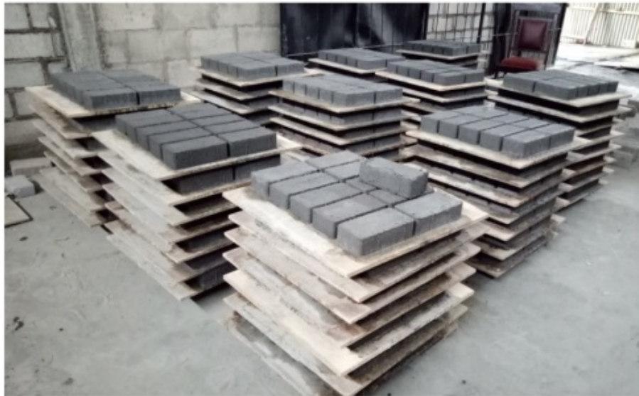
Gambar 8.14 Hasil paving diletakkan di palet multipleks
