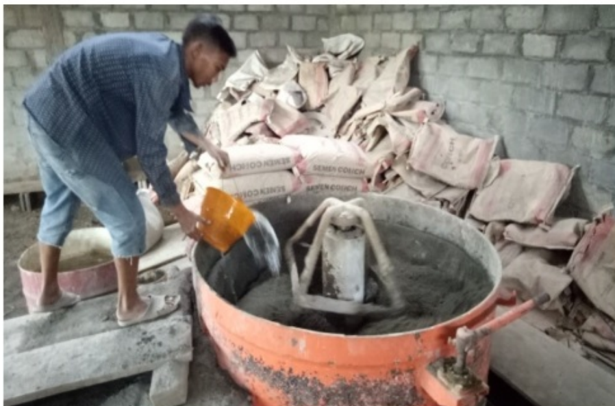
Gambar 8.9 Pemberian air ke dalam mixer
