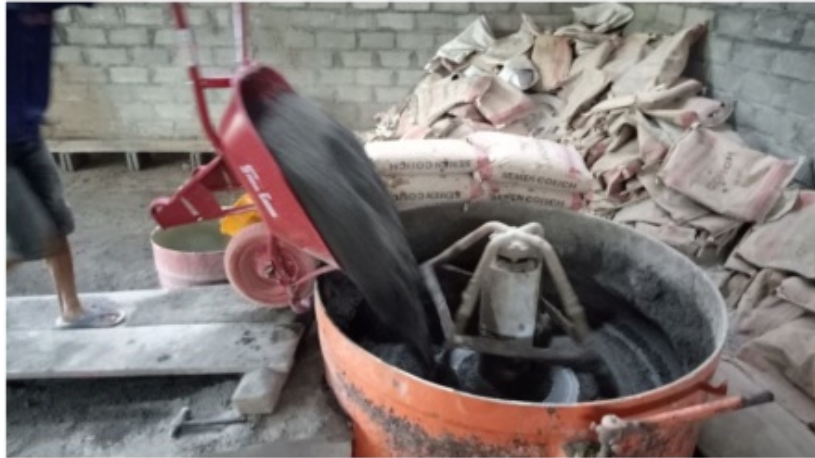
Gambar 8.6 Penuangan pasir ke mixer
