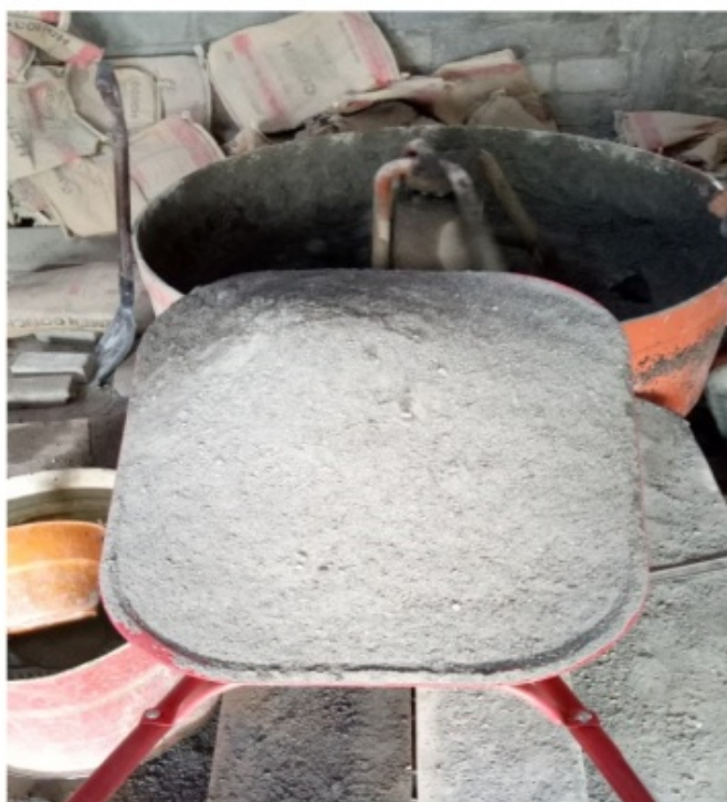
Gambar 8.5 Penuangan pasir ke mixer
