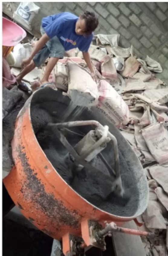
Gambar 8.7 Penuangan semen ke dalam mixer
