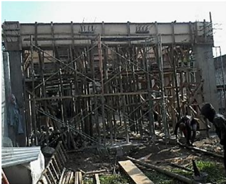
Gambar 1.2. Perancah Bambu
