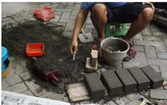
Gambar 6.2 Proses pembuatan Paving block
