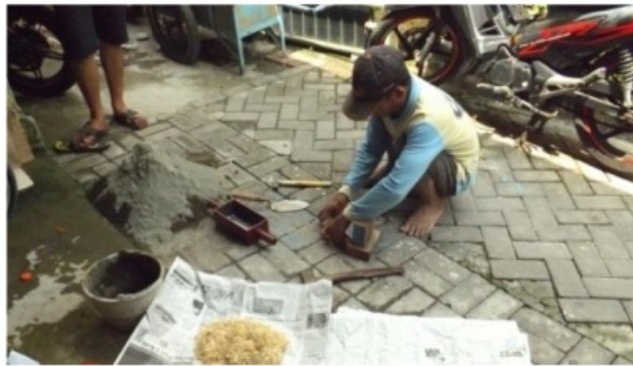
Gambar 6.1 Proses pembuatan Paving block dengan bamboo fiber
