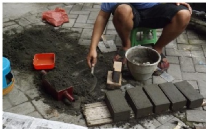
Gambar 6.2 Proses pembuatan Paving block
