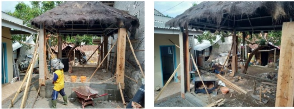
Gambar 6.23. Pekerjaan Bekisting Slof dan kolom (papan cor)
