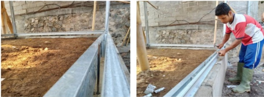
Gambar 6.20. Pekerjaan Slof dan kolom (Galvalum)
