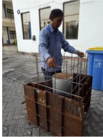
Gambar 6.5. Setting Wire Mesh Cetakan Precast Fondasi sebelum pengecoran
