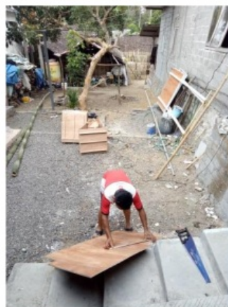
Gambar 6.17. Pelatihan perakitan contoh fondasi Pracetak dari triplek (TKT model)
