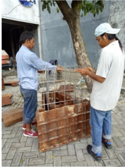
Gambar 6.7. Setting Wire Mesh Cetakan Precast Fondasi sebelum pengecoran
