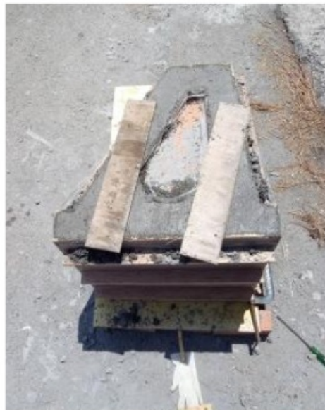
Gambar 6.10. Hasil pengecoran Fondasi
