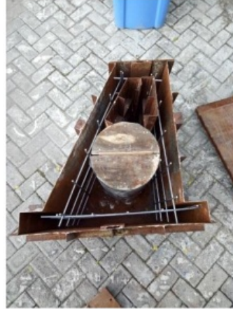
Gambar 6.5. Setting Wire Mesh Cetakan Precast Fondasi sebelum pengecoran
