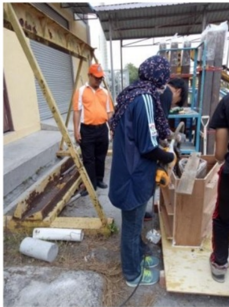
Gambar 6.9. Vibrasi pengecoran
