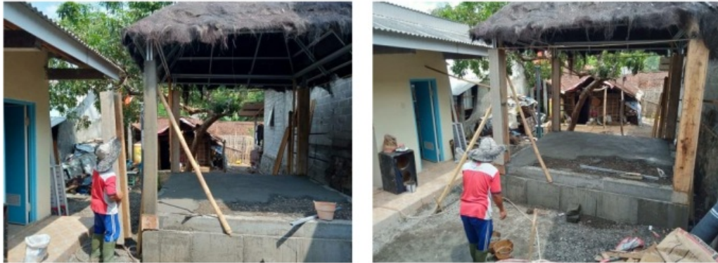
Gambar 6.25. Pekerjaan Pelepasan Bekisting Kolom
