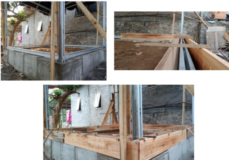
Gambar 6.21. Pekerjaan Slof dan kolom
