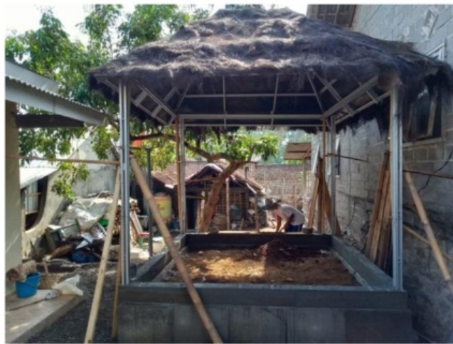
Gambar 6.22. Pekerjaan Slof dan kolom
