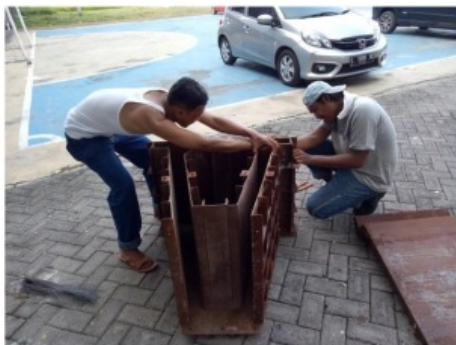
Gambar 6.6. Setting Cetakan Precast Fondasi sebelum pengecoran (model trapesium)
