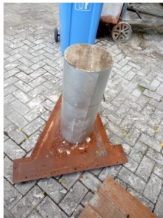
Gambar 6.4. Setting Cetakan Precast Fondasi sebelum pengecoran (model bulat)
