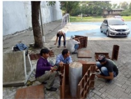
Gambar 6.4. Setting Cetakan Precast Fondasi sebelum pengecoran (model bulat)
