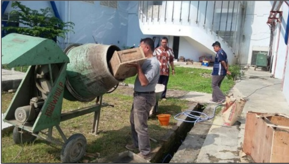
Gambar 6.3 Pencampuran Material Beton
