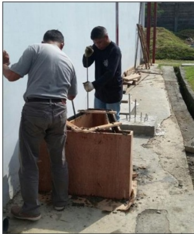
Gambar 6.4 Pemasangan/ Perojokan Beton
