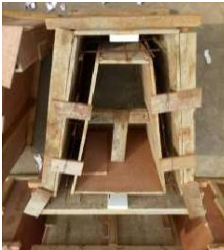
Gambar 3.14 Bekisting Fondasi Pracetak
