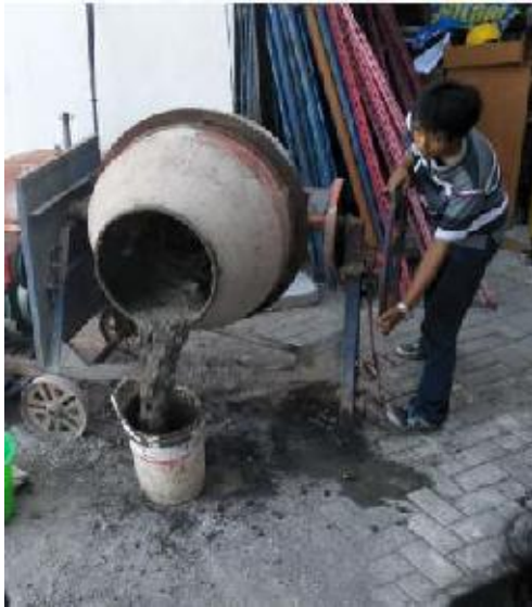
Gambar 4.5 Pembuatan motar beton fondasi Precast
