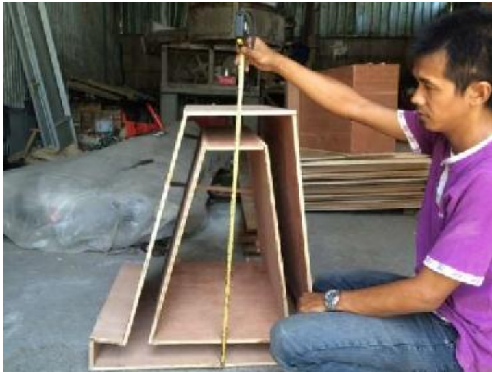
Gambar 3.12 Perangkaian bekisting fondasi pracetak
