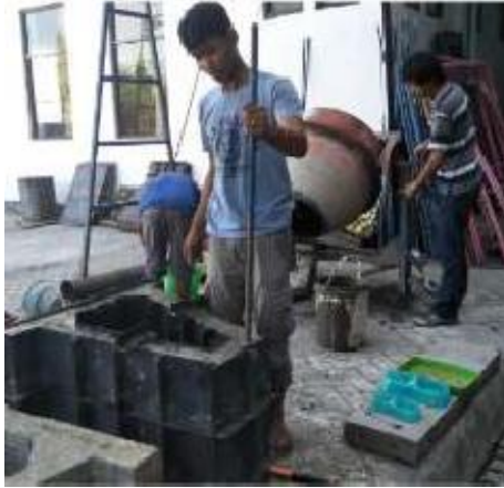
Gambar 4.7 Perojokkan beton mortar fondasi Precast
