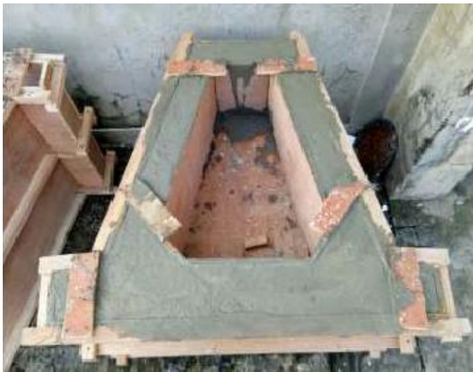
Gambar 3.18 Hasil Pengecoran dalam cetakan
