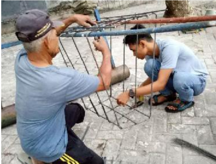
Gambar 4.2 Pembesian tulangan fondasi Precast
