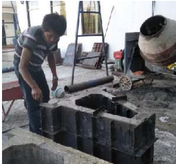
Gambar 4.8 Perapian beton mortar fondasi Precast
