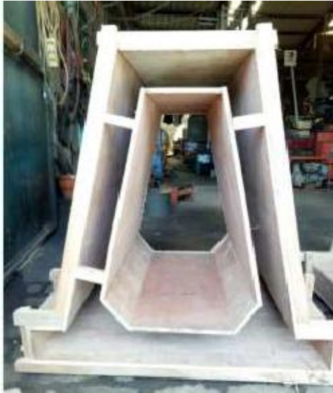
Gambar 3.15 Bekisting Fondasi Pracetak
