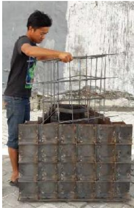
Gambar 4.4 Pembesian tulangan dimasukkan kedalam fondasi Precast
