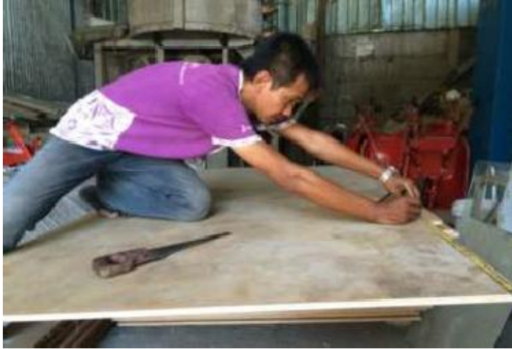
Gambar 3.10 Pemotongan Multiplek sesuai ukuran desain fondasi pracetak
