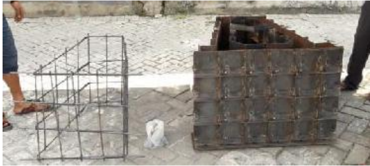
Gambar 4.3 Pembesian tulangan fondasi Precast
