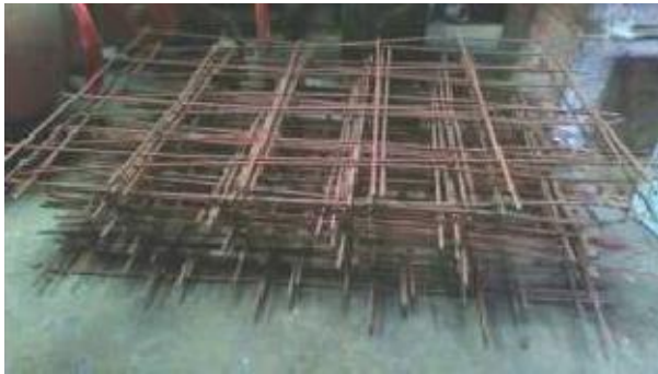
Gambar 3.13 Besi Tulangan \varnothing 6 mm Fondasi Pracetak
