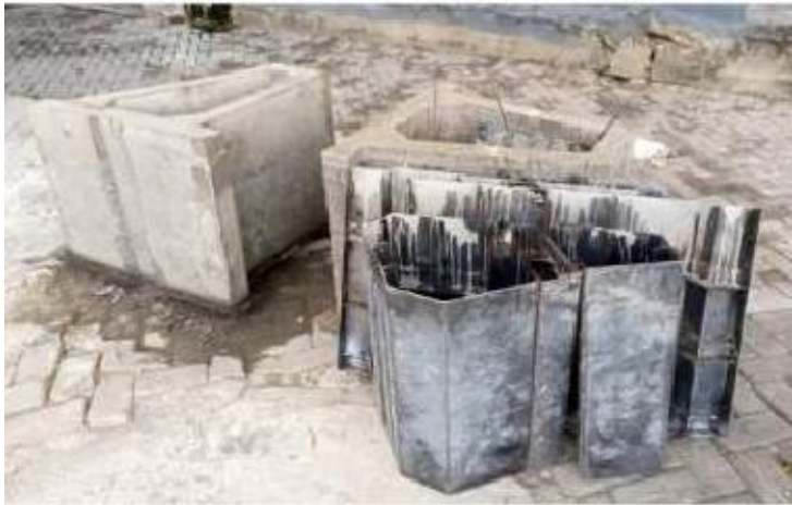
Gambar 4.9 Hasil dari fondasi Precast
