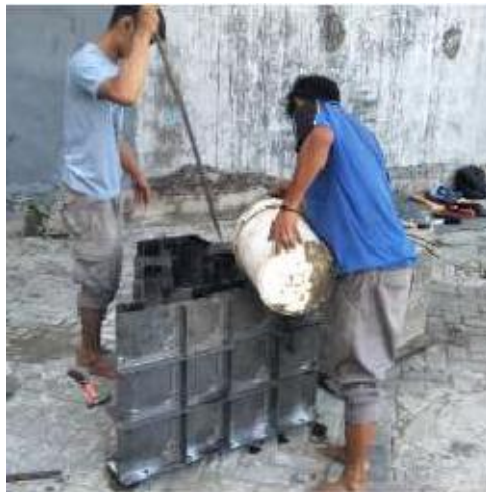
Gambar 4.6 Perojokkan beton mortar fondasi Precast
