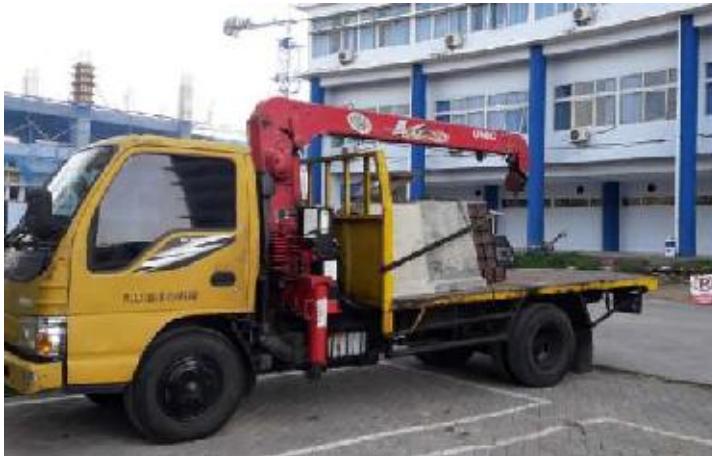
Gambar 4.11 Pengangkutan fondasi Precast
