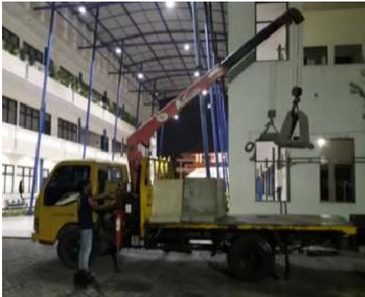
Gambar 4.10 Pengangkutan fondasi Precast
