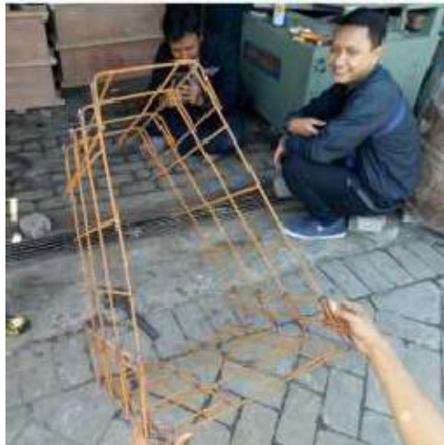
Gambar 3.16 Pembesian Bekisting Fondasi Pracetak
