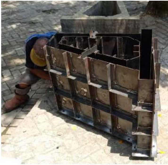
Gambar 3.24 Perakitan cetakan Precast
