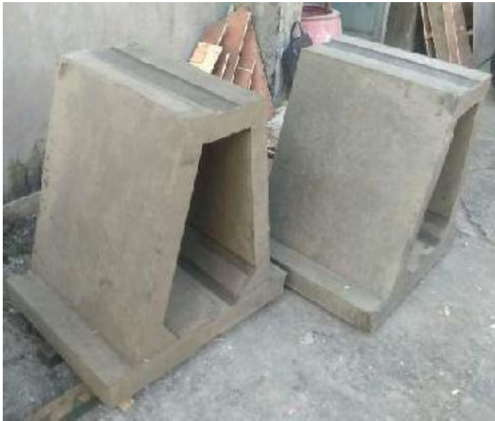
Gambar 3.20 Hasil Pengecoran lepas cetakan
