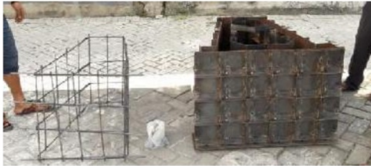
Gambar 4.3 Pembesian tulangan fondasi Precast
