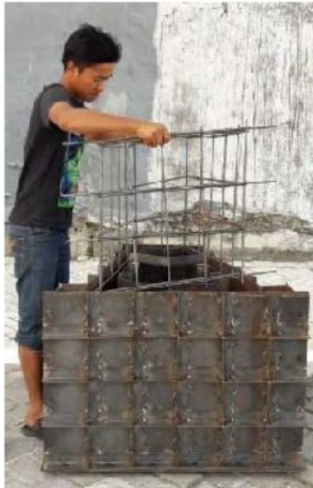
Gambar 4.4 Pembesian tulangan dimasukkan kedalam fondasi Precast
