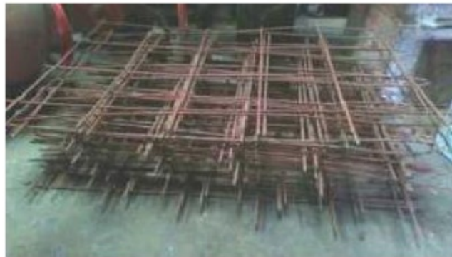
Gambar 3.13 Besi Tulangan \varnothing 6 mm Fondasi Pracetak
