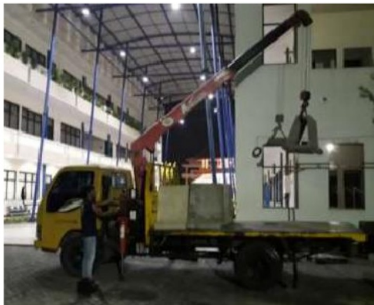
Gambar 4.10 Pengangkutan fondasi Precast
