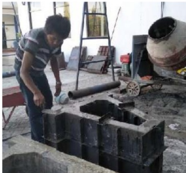
Gambar 4.8 Perapian beton mortar fondasi Precast
