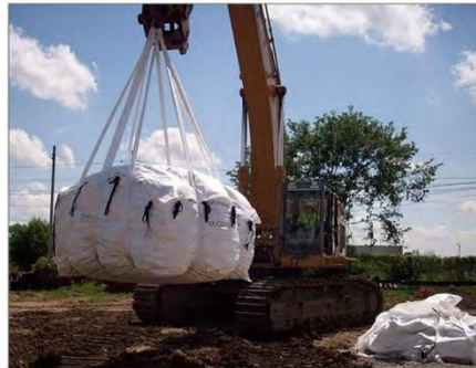
Gambar 2. 6 Contoh pengangkatan jumbo bag oleh excavator
