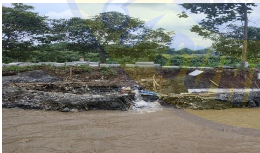
Contoh Dewatering dengan memompa pada kisdam jumbo bag
