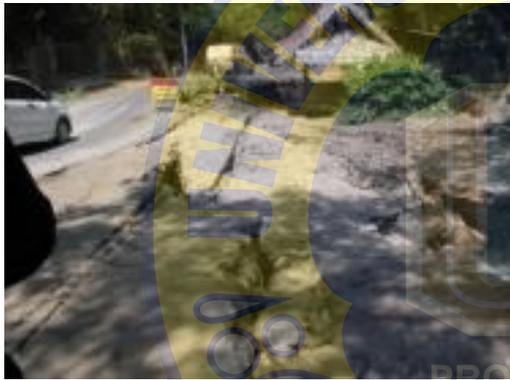
**Gambar 1-1.** *Lateral spreading* pada bagian badan jalan akibat likuifaksi. (Tim Pusat Gempa Nasional, 2018)
