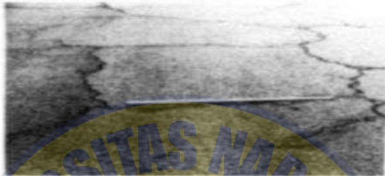
Gambar 2.6 Retak Kotak-kotak (*Block Cracking*)
