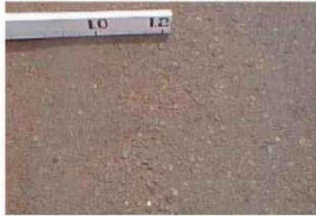
Gambar 2.15 Pengausan Agregat
