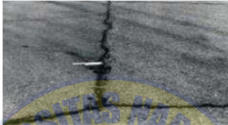
Gambar 2.11 Retak Sambung (*Joint Reflec Cracking*)
