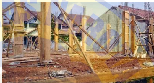
Gambar 2.1 Bekisting Konvensional
