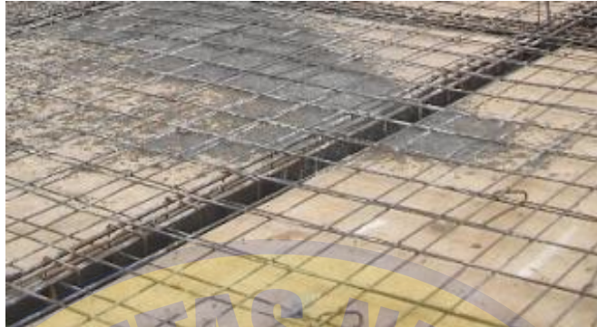
Gambar 2.1 Pelat Lantai Beton Bertulang (Sumber : Randi tandiono, 2018)
