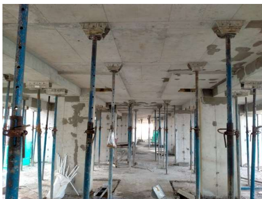
Gambar 2.11 Steel Support. (Sumber: Dokumentasi Pribadi,2021)
