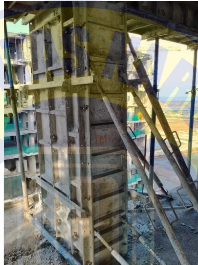
Gambar 2.15 Pemasangan Panel Bekisting Vertikal (Sumber: Dokumentasi Pribadi,2021)
