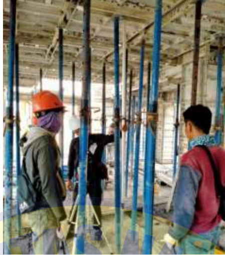
Gambar 2.16 Pengecekan Check Level Balok & Pelat. (Sumber: Dokumentasi Pribadi,2021)
