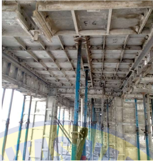
Gambar 2.13 Steel Support. (Sumber: Dokumentasi Pribadi,2021)
