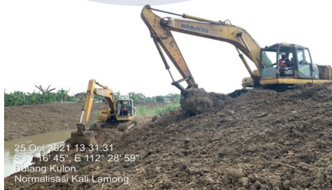
Gambar 2. 2 Excavator yang digunakan dalam Normalisasi Saluran Air Pembuang Kali Lamong
