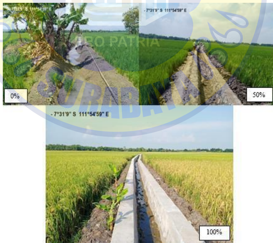
Gambar 4.3 Progres Pekerjaan P3-TGAI di desa Musir Kidul
