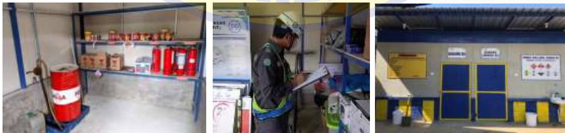
Gudang Penyimpanan Material
