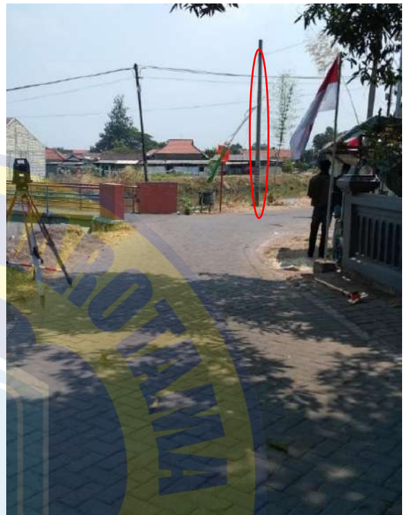
Lampiran 2 utilitas support tiang listrik sisi utara
