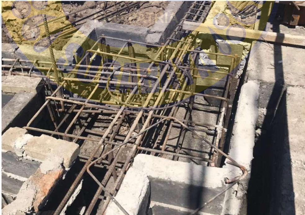
Foto Pekerjaan Pondasi Pile Cap
