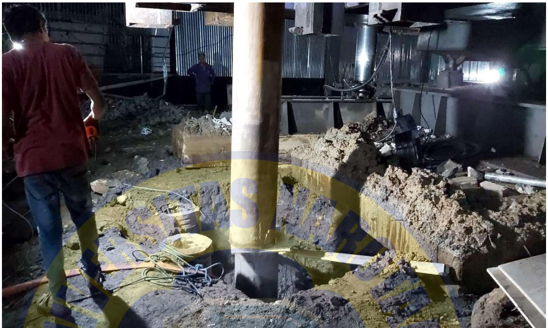
Foto Pekerjaan Test PDA Tiang Pancang
