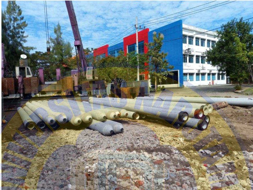
Foto Pekerjaan Tiang Pancang
