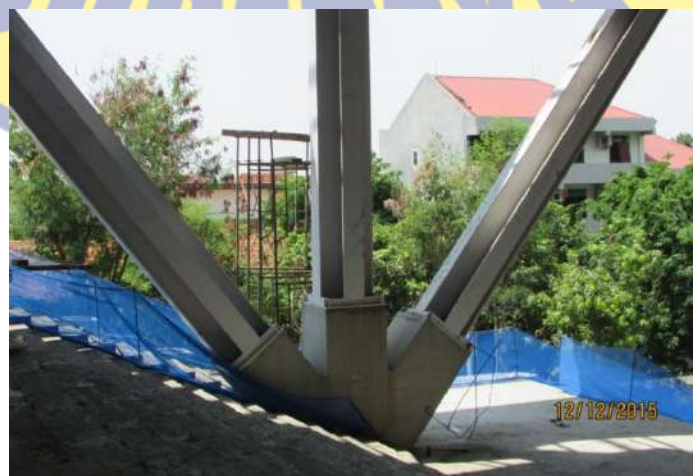
Gambar 4.175. Foto hasil kolom W dilapangan
