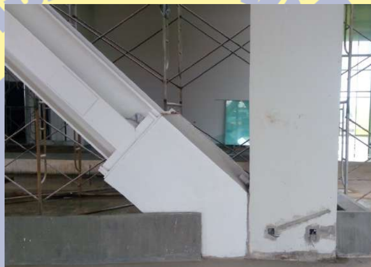
Gambar 4.180. Foto hasil kolom Y dilapangan
