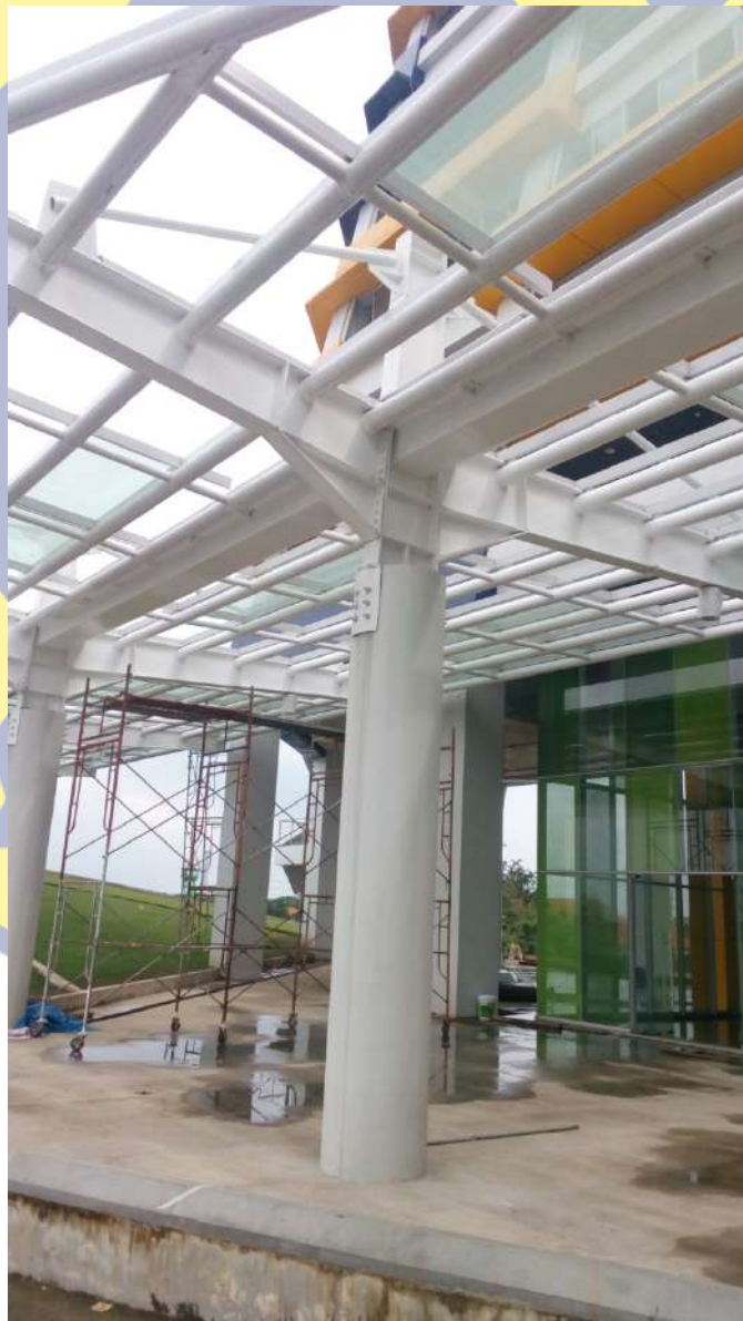
Gambar 4.196. Foto hasil kolom canopy dilapangan
