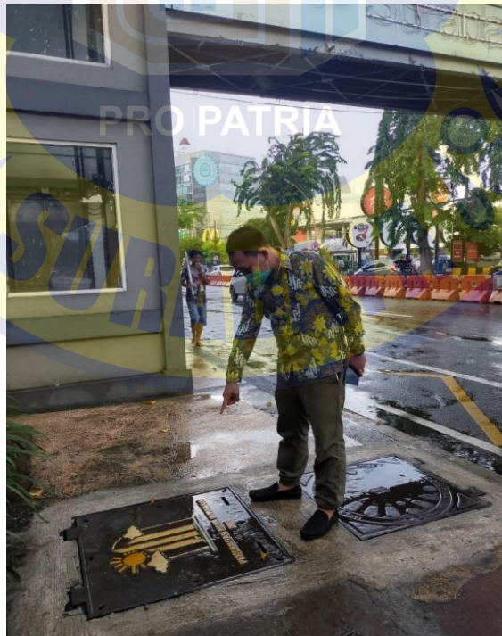
Gambar 4.4 Fasilitas Penutup Saluran pada Jalur Pedestrian
