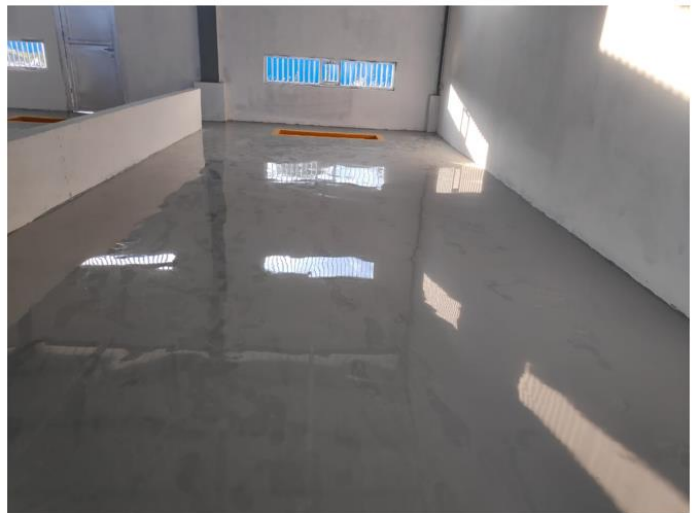
Finsihing Pekerjaan Lantai
