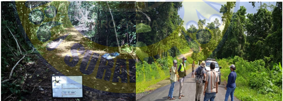
Gambar 4. 11 Penampakan Pembangunan jalan Arfai Pami 31 km sebelum dan setelah terbangun
