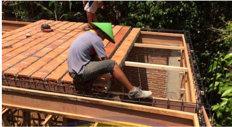
Gambar 10 Penampang Pemasangan Dak Keraton
