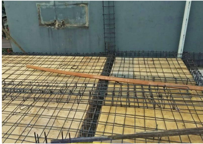
Gambar 14 Penampang Bekisting Plat Lantai Konvensional
