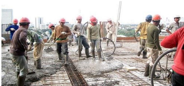
Gambar 5 Pengecoran Plat Lantai Metode Konvensional
