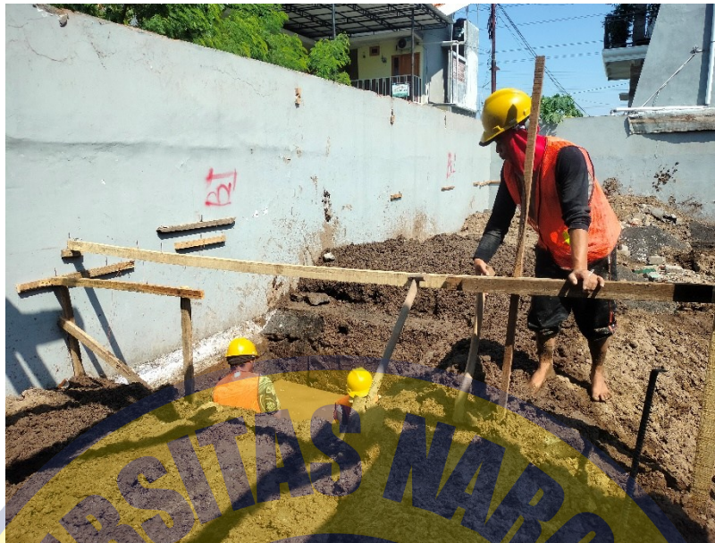
Gambar 4.1 Pekerjaan pengalihan pondasi
