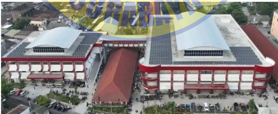
Gambar 4. Pembangkit Listrik Tenaga Surya (PLTS) Rooftop Gedung Pasar Gede Klaten
