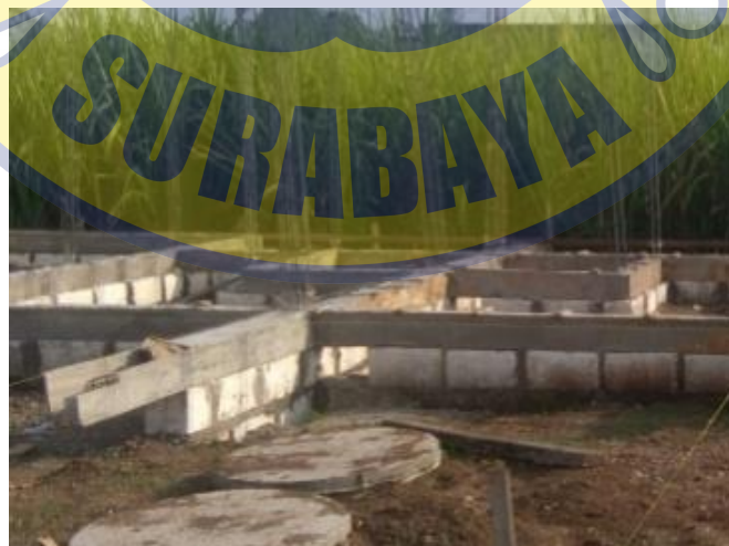
Gambar 4. 3 Pekerjaan Sloof (Sumber : Dokumentasi Pribadi, 2023)
