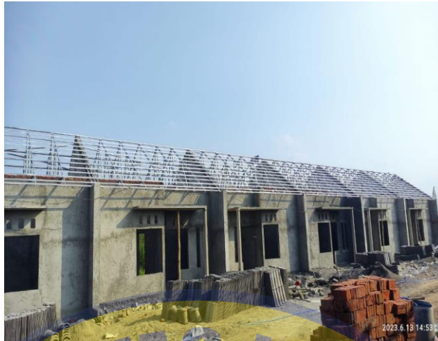
Gambar 4. 8 Pekerjaan Plester + Acian (Sumber : Dokumentasi Pribadi, 2023)
