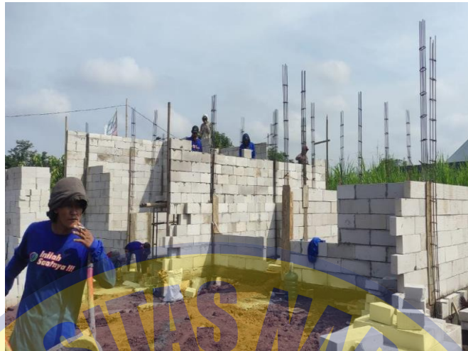
Gambar 4. 4 Pekerjaan Kolom (Sumber : Dokumentasi Pribadi, 2023)
