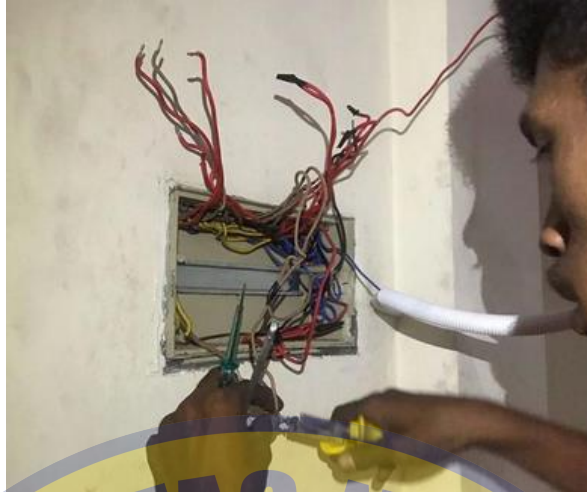
Gambar 4. 14 Pekerjaan Pasang Elektrikal (Sumber : Dokumentasi Pribadi, 2023)
