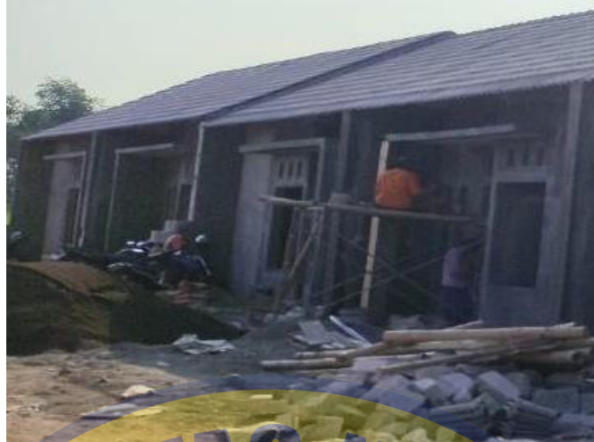
Gambar 4. 6 Pekerjaan Plat Beton Canopi (Sumber : Dokumentasi Pribadi, 2023)
