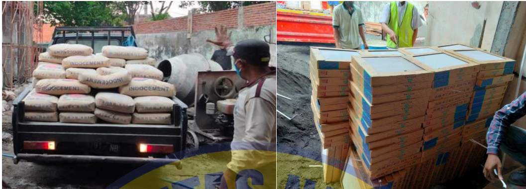
Gambar 4. 21 Pengecekan Material (Sumber : Dokumentasi Pribadi, 2023)
