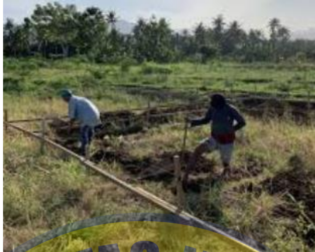
Gambar 4. 1 Dokumentasi Pekerjaan Bouwplank (Sumber : Dokumentasi Pribadi, 2023)
