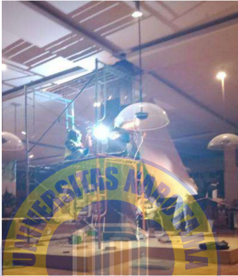
Gambar 4. 11 Pengikatan dengan Penjepit atau Pengelasan
