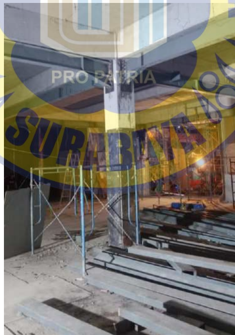
Gambar 4. 10 Sabuk Baja sebagai Penguatan Lateral
