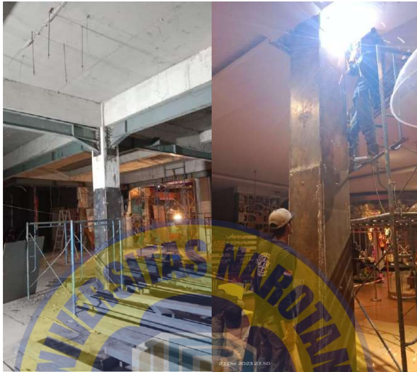
Gambar 4. 8 Penggunaan Baut Berdaya Tinggi dan Teknik Pengelasan
