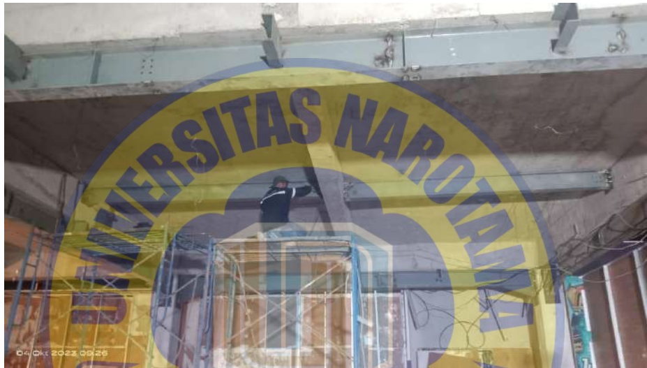
Gambar 4. 7 Pemasangan Plat Baja Wf Pada Titik-Titik Kritis
