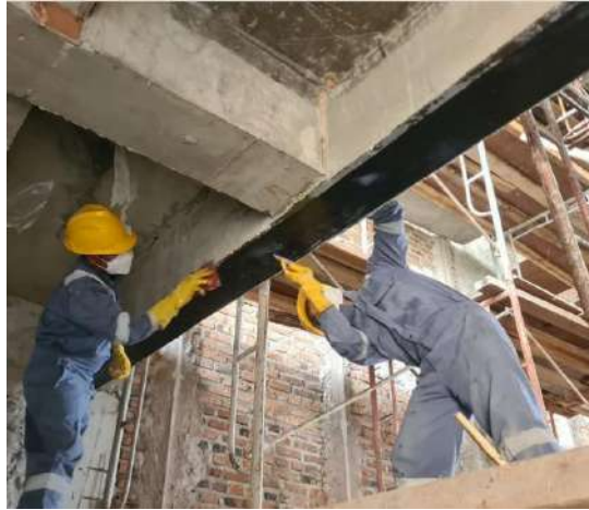
Gambar 4. 48 Ilustrasi Pemasangan CFRP
