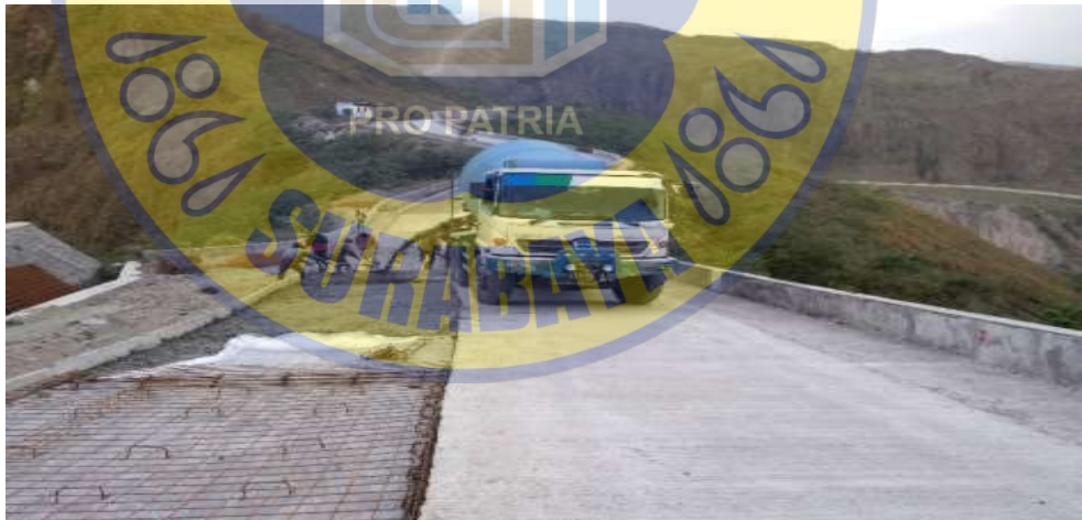
Gamba 4.11 Pekerjaan Pengecoran Mutu K-175
