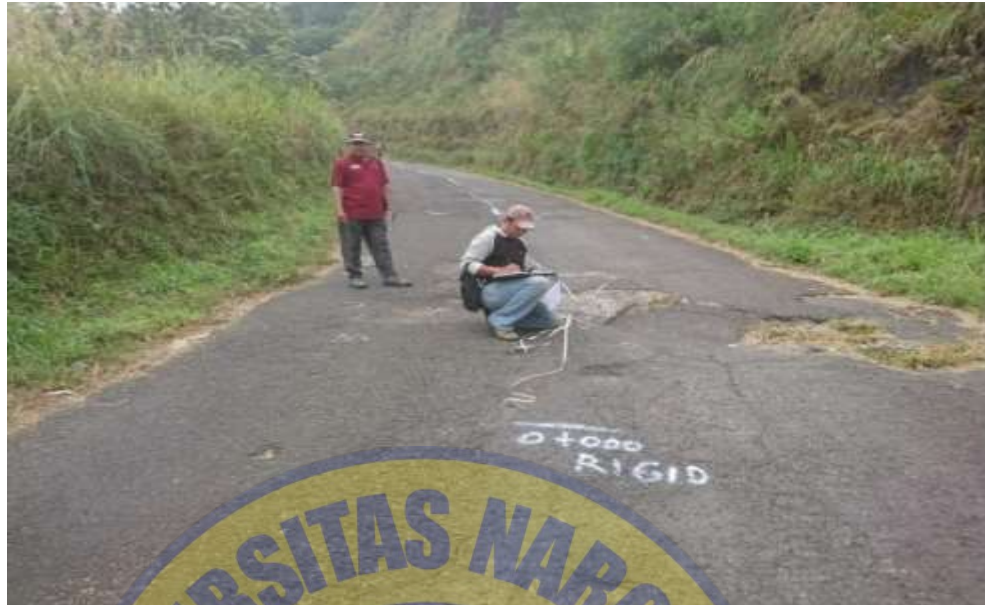
Gambar 4.7 Salah satu foto pekerjaan persiapan berupa Uitzet
