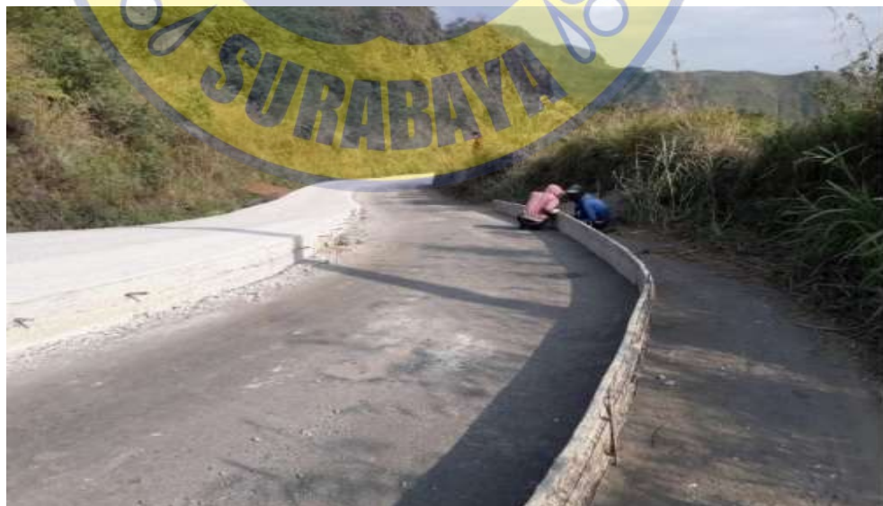
Gambar 4.8 Pekerjaan Bekisting Pada Beton
