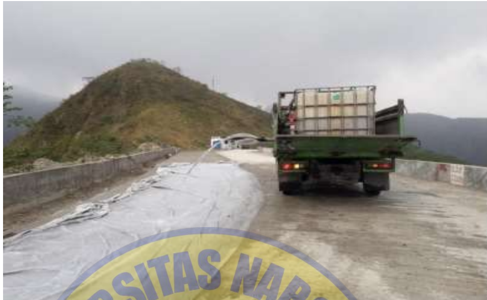
Gambar 4.13 pekerjaan curing beton
