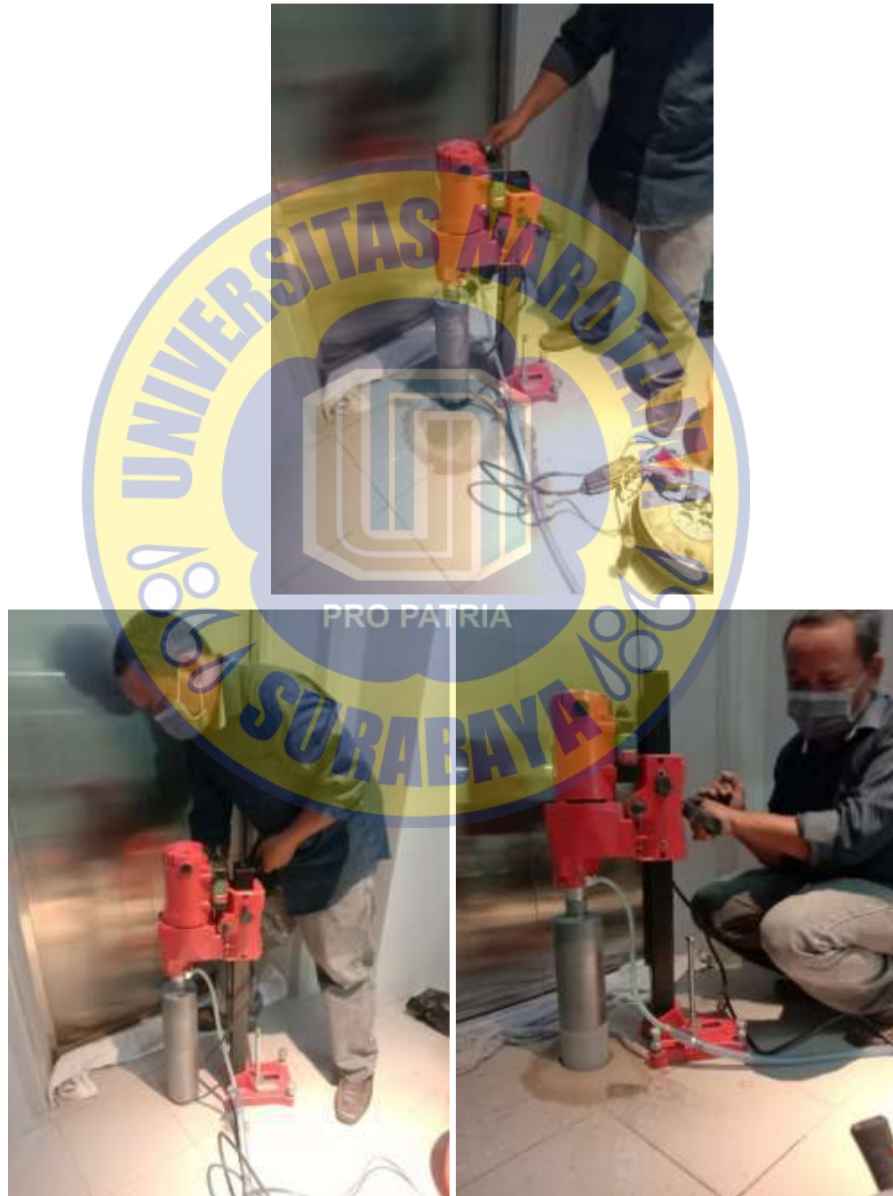
Gambar 4. 45 Dokumentasi Pengambilan Sampel Kuat Tekan Benda Uji Silinder
