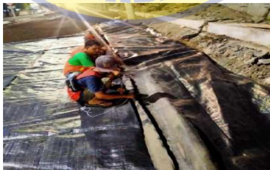
Gambar 4.11 Pemasangan dan penjahitan Geotex Atas Sumber: Dokumentasi Pribadi
