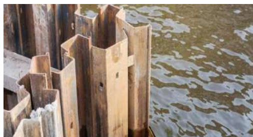
Gambar 2.8 Dinding Kantilever Sheet Pile Sumber: Dokumentasi Pribadi
