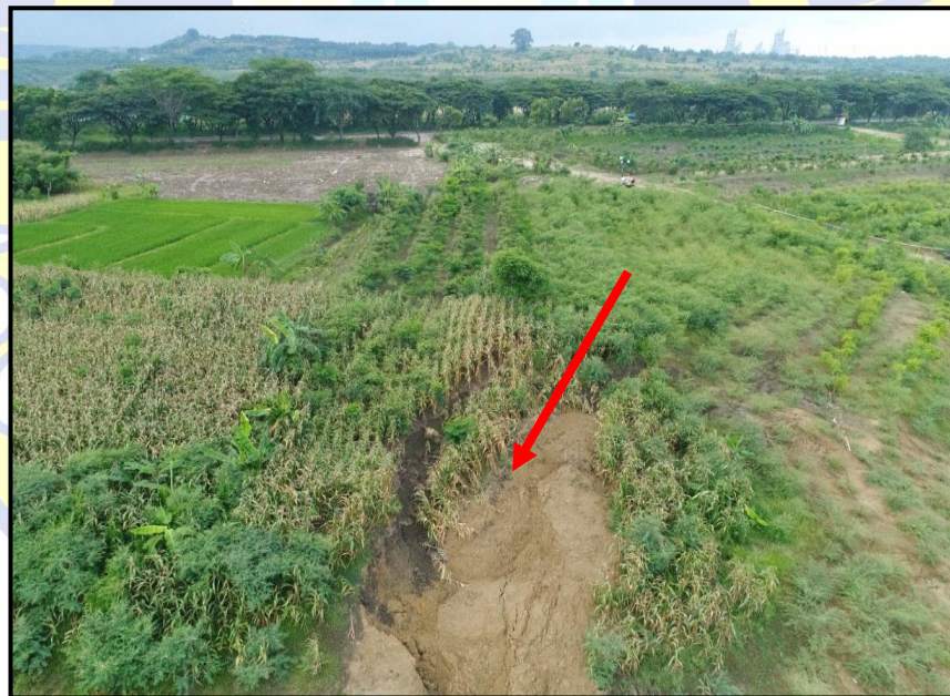
Gambar 1-2. Longsoran pada lereng ( Quarry Clay Mliwang Timur PT. Semen Indonesia Pabrik Tuban )
