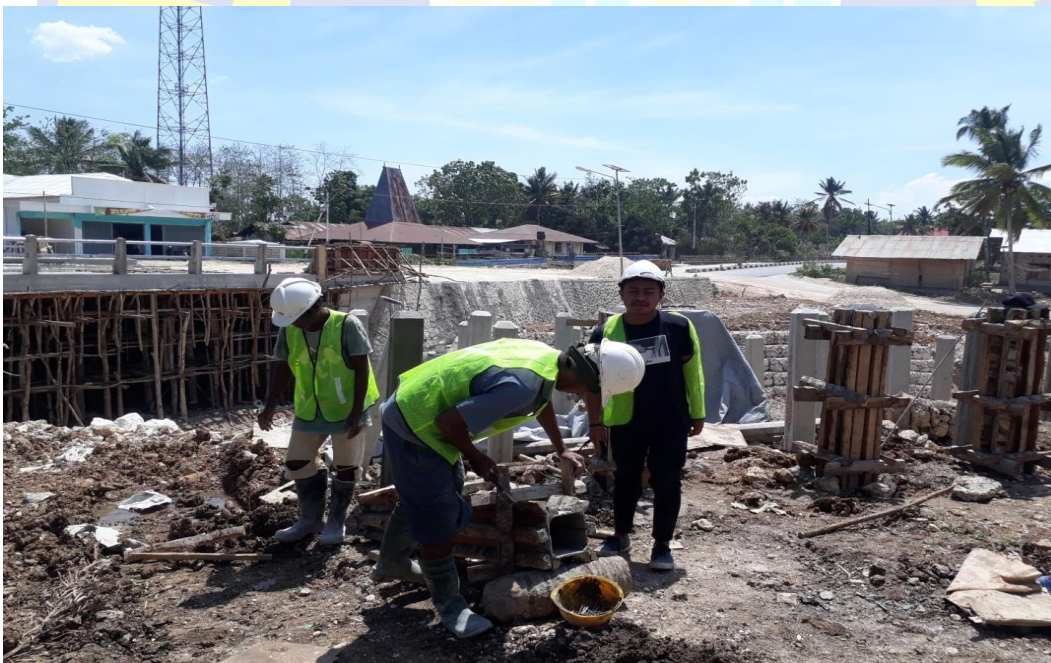
Gambar 4. Para pekerja di lapangan masi menggunakan peralatan seadanya
