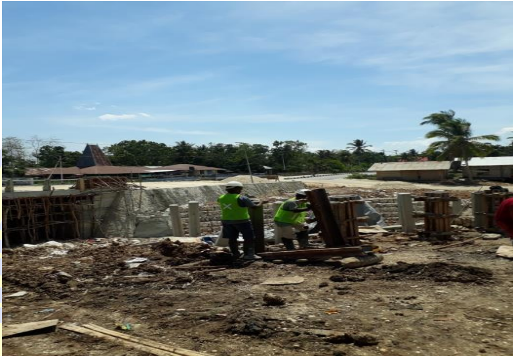
Gambar 1. Proses pekerjaan di lapangan dengan perlengkapan k3 yang digunakan belum memenuhi standar.
