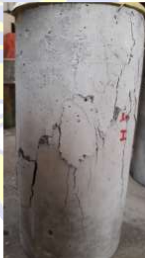
Kerusakan pada kode uji 30%
