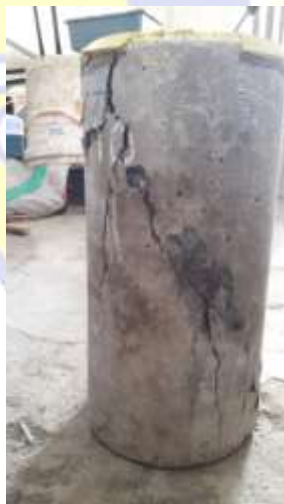
Kerusakan pada kode uji 10%
