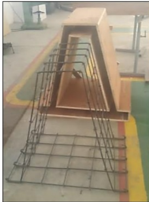
Gambar 5.3 Cetakan Bekisting & Wire Mesh II
