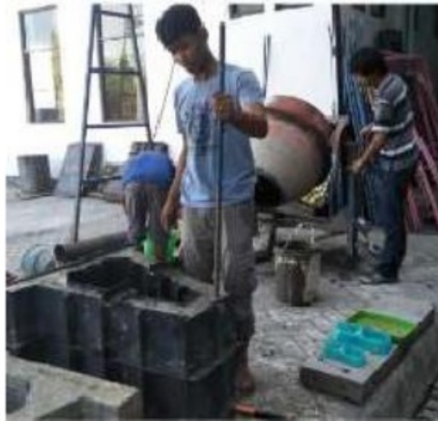
Gambar 4.7 Perojokkan beton mortar fondasi Precast
