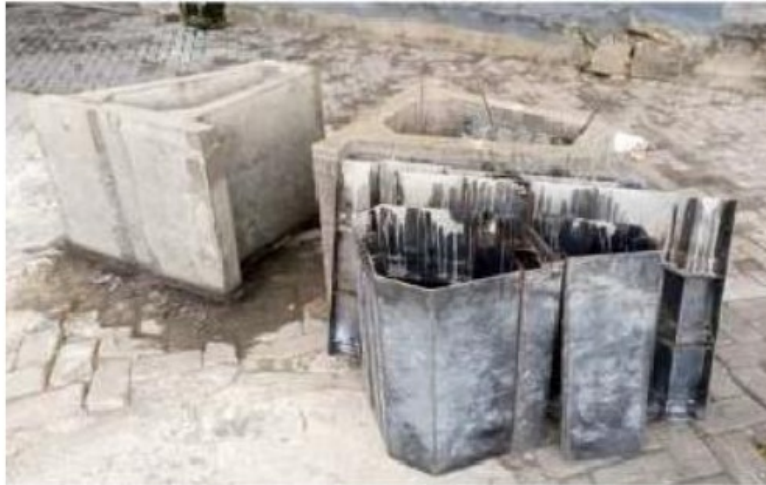
Gambar 4.9 Hasil dari fondasi Precast
