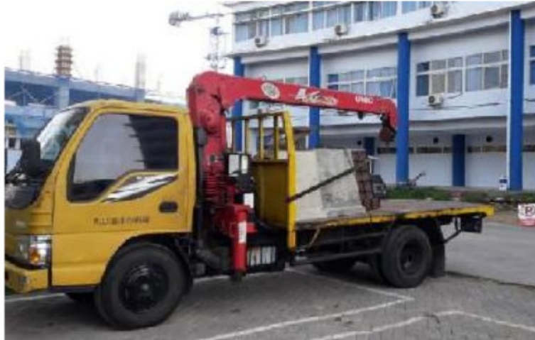
Gambar 4.11 Pengangkutan fondasi Precast
