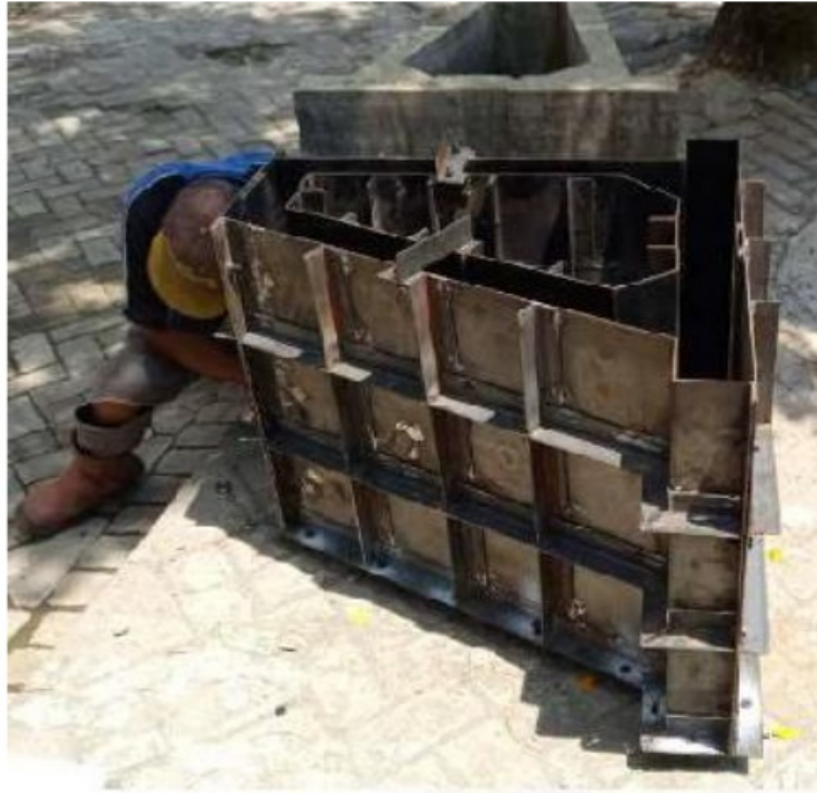
Gambar 3.24 Perakitan cetakan Precast
