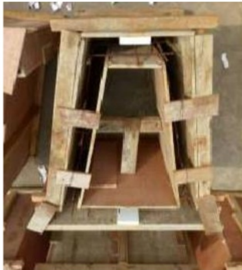
Gambar 3.14 Bekisting Fondasi Pracetak
