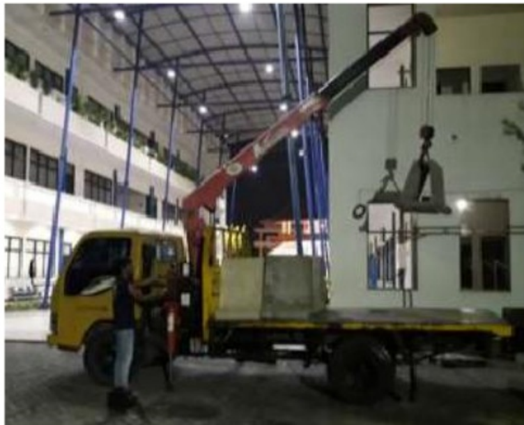
Gambar 4.10 Pengangkutan fondasi Precast
