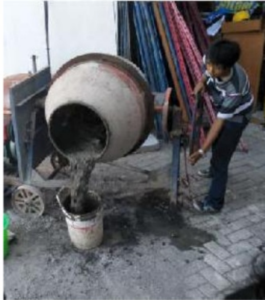
Gambar 4.5 Pembuatan motar beton fondasi Precast
