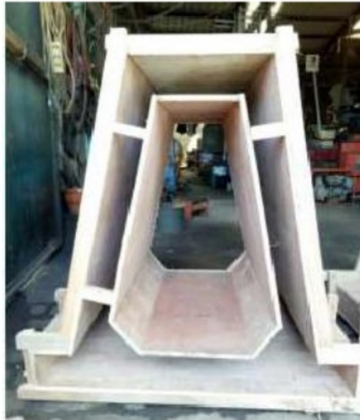
Gambar 3.15 Bekisting Fondasi Pracetak
