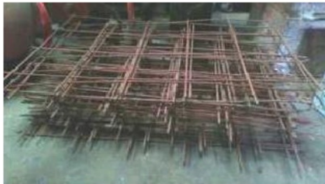
Gambar 3.13 Besi Tulangan \varnothing 6 mm Fondasi Pracetak
