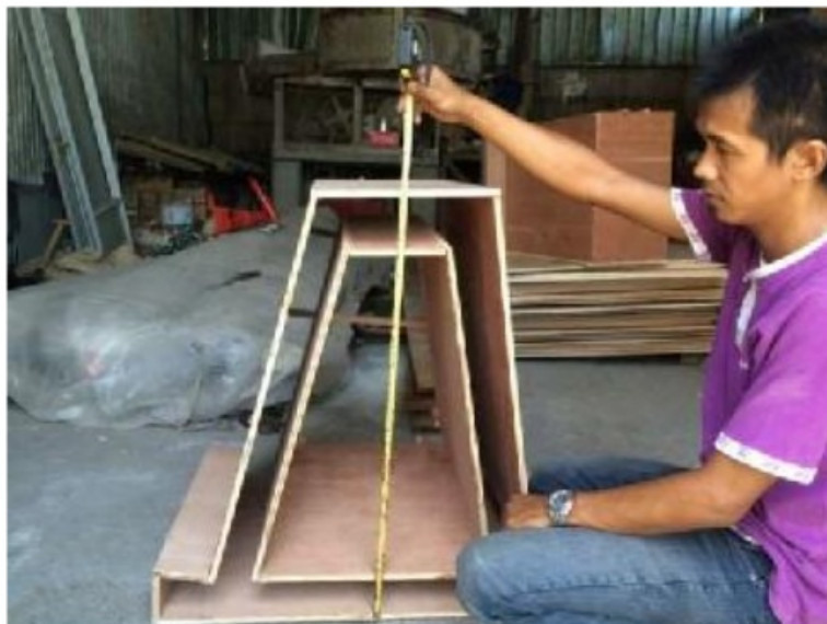
Gambar 3.12 Perangkaian bekisting fondasi pracetak
