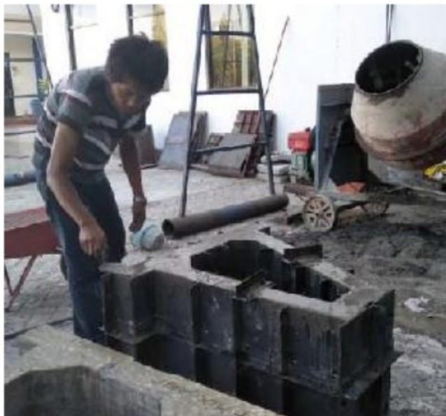
Gambar 4.8 Perapian beton mortar fondasi Precast
