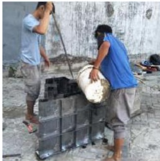
Gambar 4.6 Perojokkan beton mortar fondasi Precast
