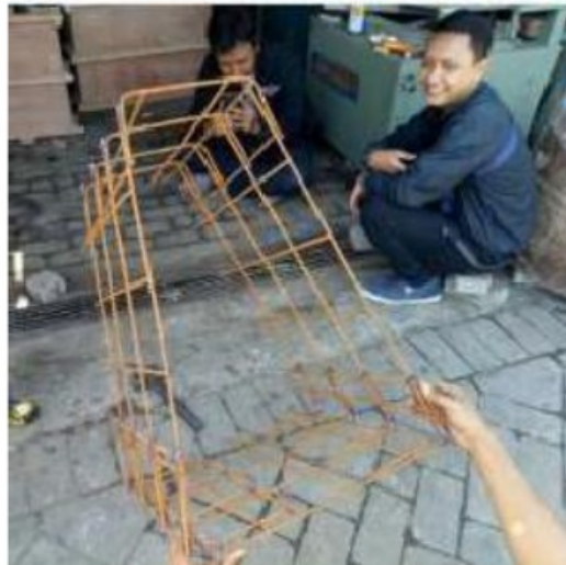
Gambar 3.16 Pembesian Bekisting Fondasi Pracetak
