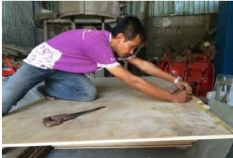
Gambar 3.10 Pemotongan Multiplek sesuai ukuran desain fondasi pracetak
