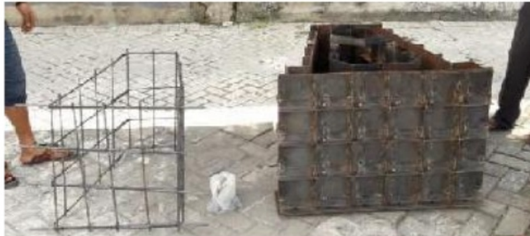
Gambar 4.3 Pembesian tulangan fondasi Precast
