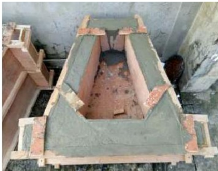
Gambar 3.18 Hasil Pengecoran dalam cetakan
