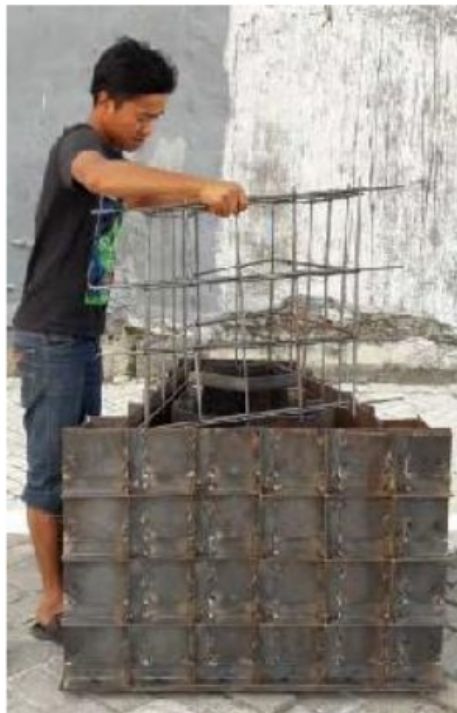
Gambar 4.4 Pembesian tulangan dimasukkan kedalam fondasi Precast
