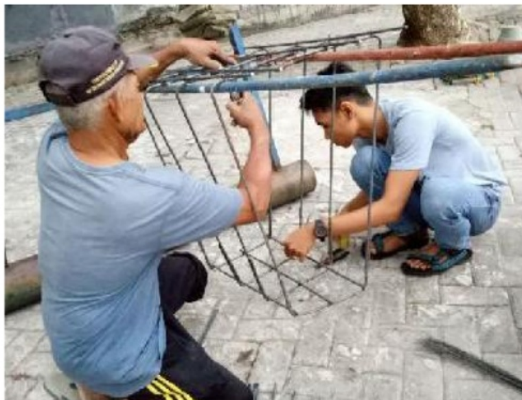
Gambar 4.2 Pembesian tulangan fondasi Precast
