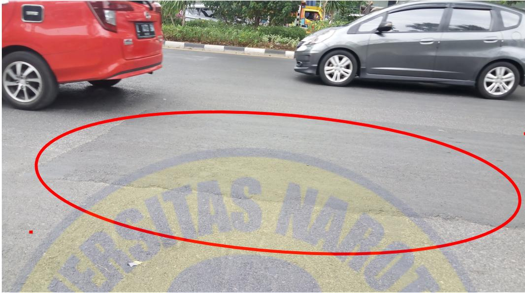
Gambar 4.7. Perkerasan yang ditambal tidak rapi
