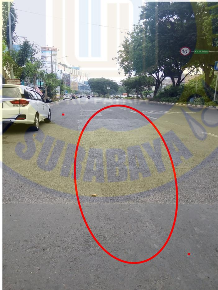
Gambar 4.8. Perkerasan yang ditambal tidak rapi
